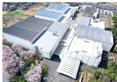
収集資料の保管施設
